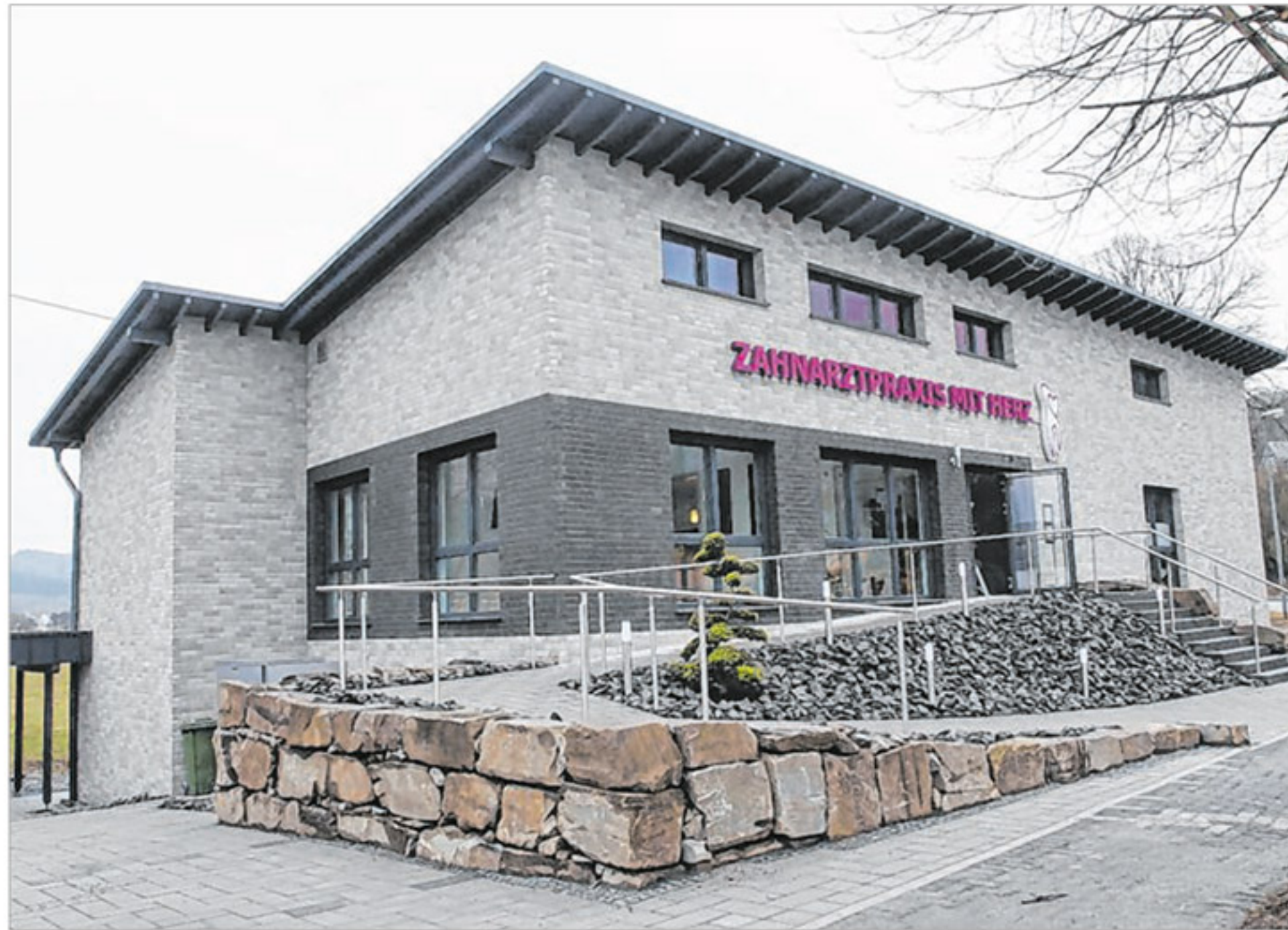
Die Zahnarztpraxis mit Herz ist künftig an einem neuen Standort zu finden. Der Neubau ist fertiggestellt und soll Interessierten am kommenden Dienstag während eines Tages der offenen Tür vorgestellt werden.
